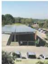
Répartis sur 2 600 m 2 , les panneaux couvrent le parking du siège social d'Eskom.
