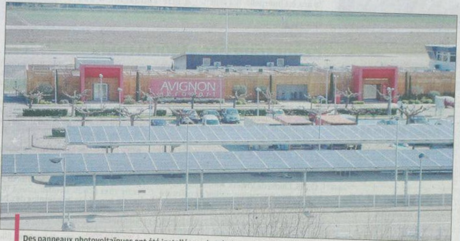
Des panneaux photovoltaïques ont été installés sur le toit du parking de l'aéroport par l'entreprise "Coruscant". Ils produisent l'équivalent de la consommation annuelle de 34 foyers.
